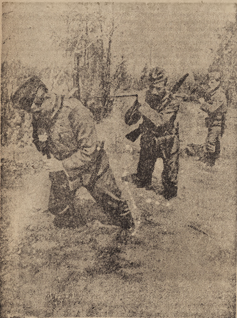
NIEMIECKI ODDZIAŁ ŁĄCZNOŚCI ZAKŁADA KABEL W ZALANYM PRZEZ ROZTOPY TERENIE
