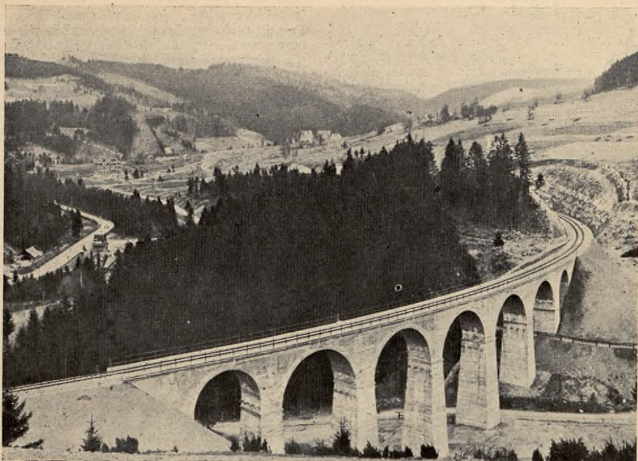
Wisła — Wiadukt kolejowy pod Głębcami. Ze zb. W. T. M. K. — Fot. Dańda Józef, Katowice.
