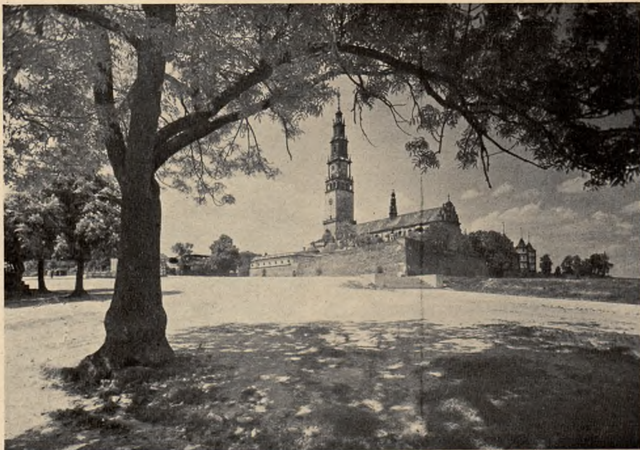
Kościół na Jasnej Górze ze słynną wieżą, widzianą zdaleka. Ze zb. W. T. M. Komunikacji — Fot. Henryk Podębski, Warszawa.
