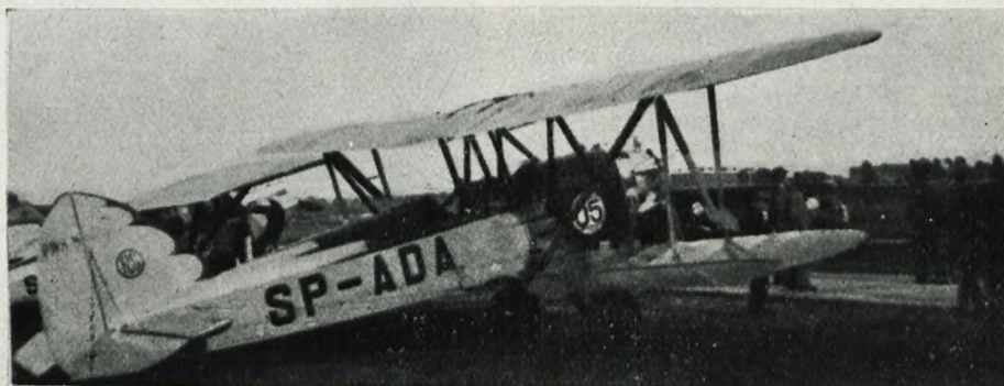
Awionetka Państw. Zakładów Lotniczych PZL 5 z silnikiem Gipsy 85 MK.
