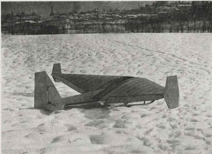
Szybowiec „Bertina” konstrukcji jednego z filarów włoskiego szybownictwa, członka komisji szybowcowej F. A. I. p. Vittorio Bonomi. — Szybowiec ten, o niesłychanie małej wadze (42 kg.) i oryginalnej konstrukcji, jest zbudowany specjalnie do startów i lądowania na śniegu.
