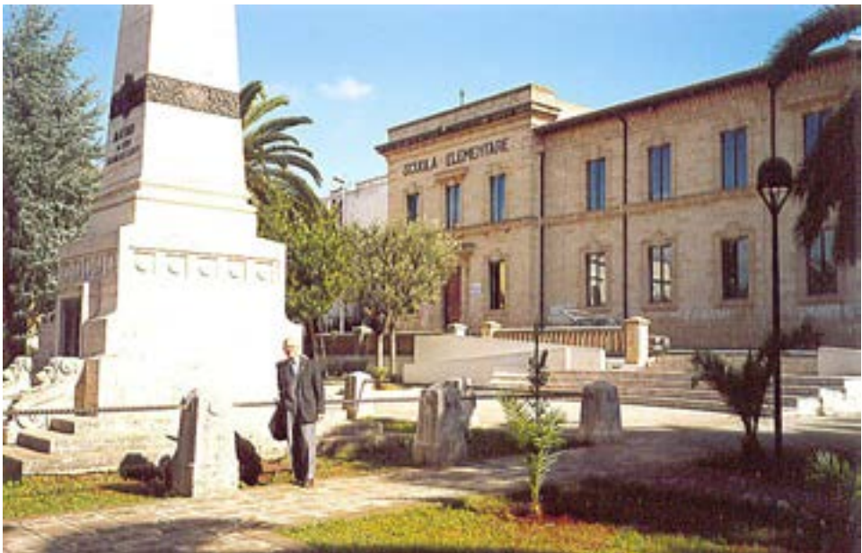
Ryc. 22. Matino. Budynek szkolny, w którym działały Kursy Maturalne Nr 2 (widok obecny)
