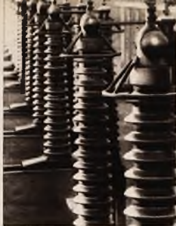
U góry: Porcelanowe izolatory, podtrzymujące przewody o wysokim napięciu. — U dołu: Zespół lamp modulujących w nadawczej stacji radiowej.
