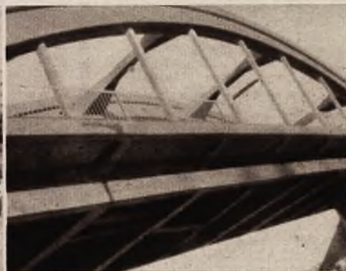
Poniżej: Jeden z betonowych wiaduktów nad torami kolejowymi w Gdyni.
