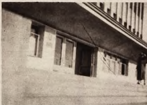
Główne wejście do gmachu dworca morskiego w Gdyni.
