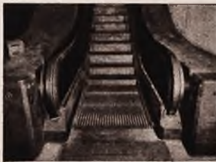
Na lewo: Automatyczne schody w Metro paryskim, które zapomocą promieni infraczerwonych i komórki fotoelektrycznej wprawiane są w ruch, gdy pasażer na nie wejdzie.
