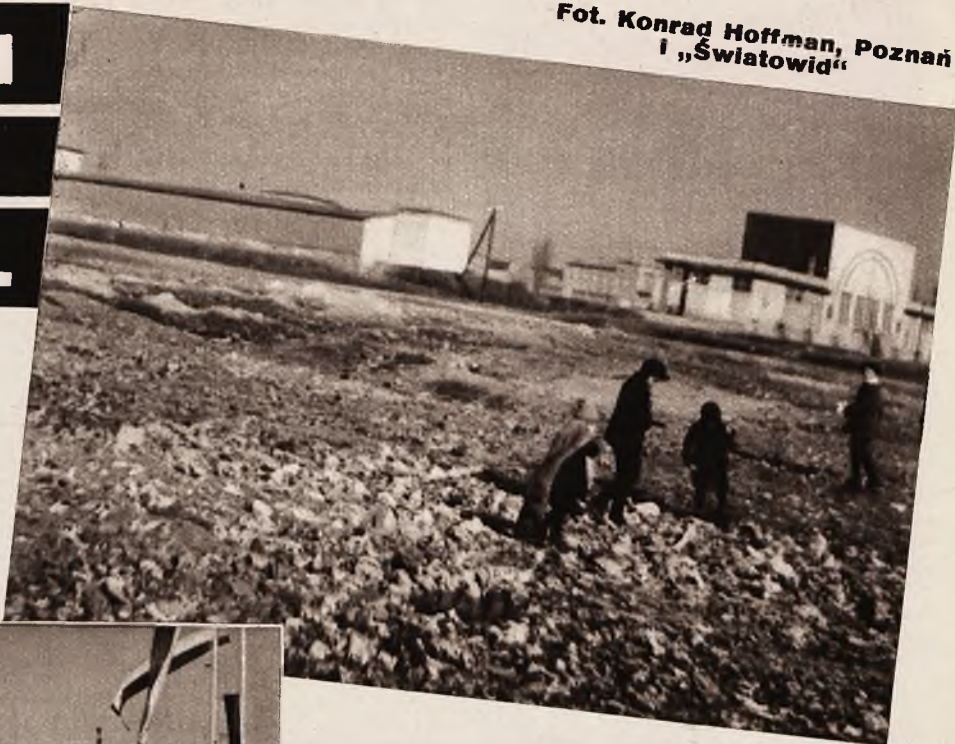
Na pustych placach po Pewuce pozostały obecnie śmietniki, będące terenem dla młodocianych poszukiwaczy skarbów.
