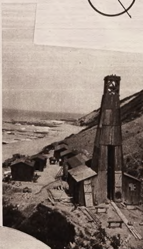
W Punta Ferdigua rozpoczęto prace pomiarowe na głębokości 500 metrów, których rezultaty mają posłużyć do realizacji projektu tunelu podmorskiego.
