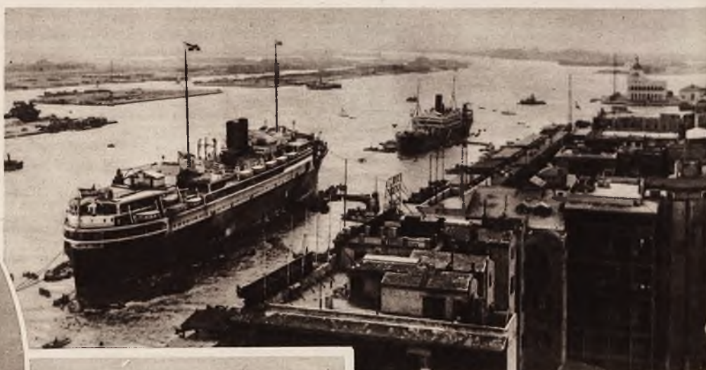
Ogólny widok urządzeń portowych przy wejściu do kanału Suezkiego.
