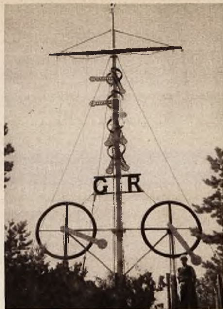
Maszt sygnalowy na Helu. Uwidocznione zestawienie sygnałów wskazuje, że w Gdyni wiatr posiada natężenie 80 według skali Baufora, o kierunku południowo-wschodnim, zaś na Rozewiu siłę poniżej 60.
