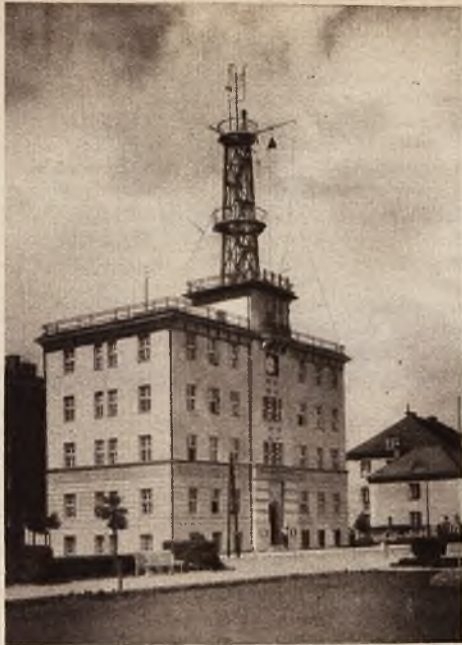
Gmach PIM-a w Gdyni z wieżą, na której wywieszają się sygnały ostrzegawcze.
