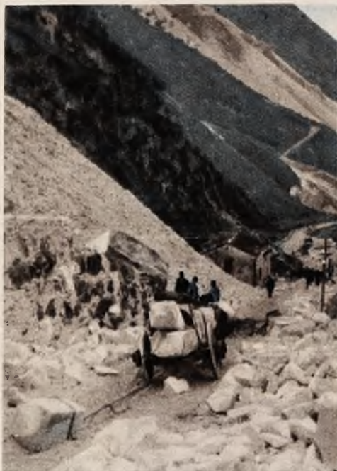
Na lewo: Zwózka bloków marmuru. Bryła przymocowana z tyłu wozu służy jako hamulec.
