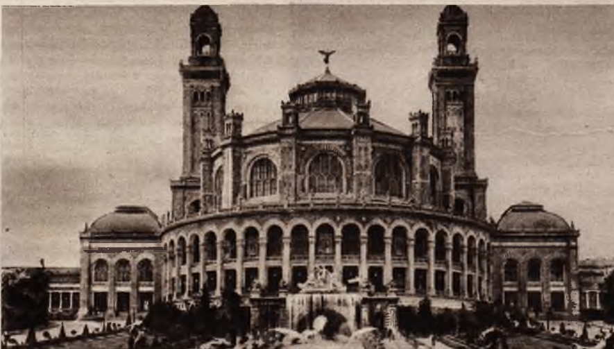
Centralny budynek Trocadera przed zburzeniem.
