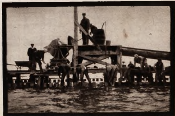
Poniżej: Praca przy betoniarce na molu. Fot. R. Burzyński.
