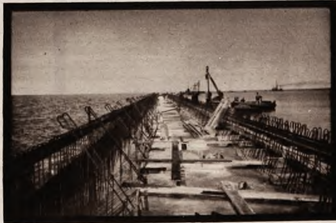
Poniżej: Po ułożeniu pierwszej płyty żelbetonowej przygotowane pręty żelazne pod boczne ściany betonowej mola portowego. Fot. R. Burzyński.
