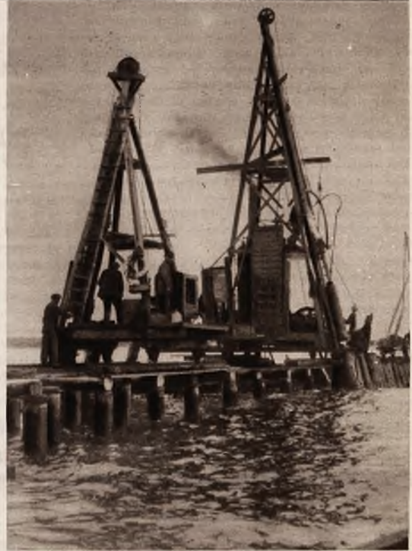
Potężne kafary motorowe wbijają słupy w dno morza pod molo portu rybackiego w Wielkiej Wsi-Hallerowie.
