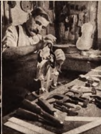
Poszczególne fazy budowy skrzypiec (od lewej): Wycinanie otworów rezonansowych w kształcie litery f. — Przytwierdzanie boków, które łączą górną i dolną płytę skrzypiec. — Wprawianie szyjki — Sprawdzanie mierzury skrzypiec. (Zdjęcia z „francuskiej Cremony” — Mirecourt).
