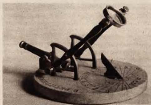
Słoneczny zegar wyposażony w małą armatkę, której lont zapalają rzucone przez słońce promienie punktualnie o 12 w południe.
