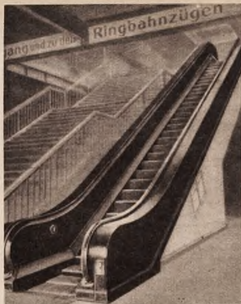
Ruchome schody na jednym z dworców w Berlinie, które zaczynają działać przy pomocy fotoceli, wbudowanej w poręcz (widoczne kółko z lewej strony).
