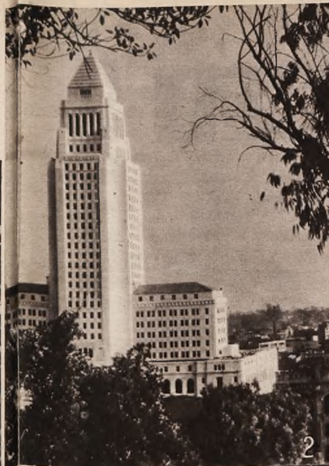
Powyżej i na prawo: ratusz w Los Angeles w Kaliforniji. — Ten sam budynek widziany z lotu ptaka. (Nr. 2).
