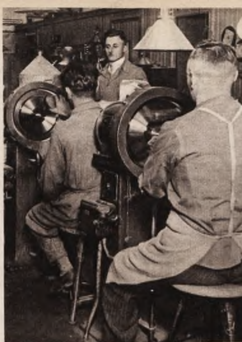
Czyszczenie matryc miedzianych, z których odbija się nagrania.
