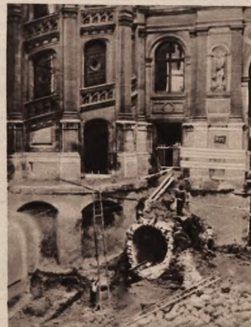
Budowa schronu przeciwigazowego na podwórzu ratusza paryskiego.
