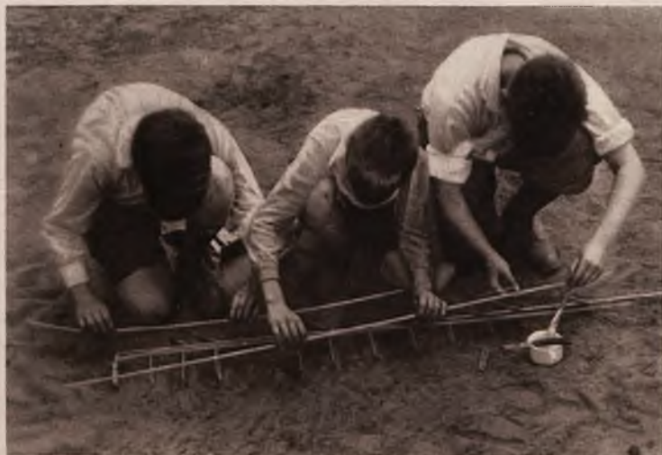
Dobieranie i sklepanie długich listewek, które tworzą kadłub modelu. Zdjęcia: Fot. C. Anders — Paryż.
