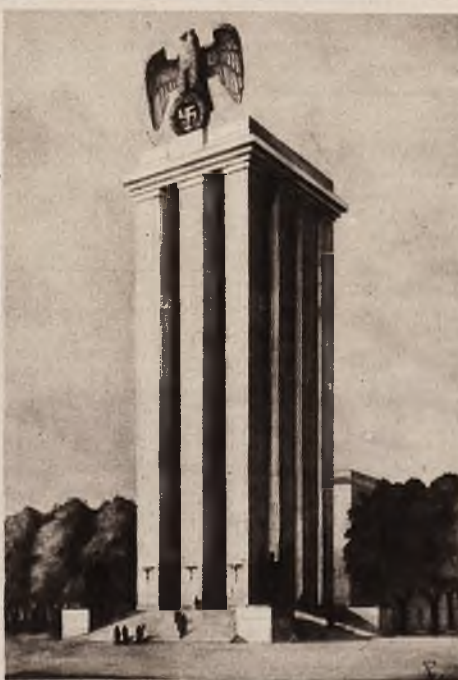
Wieża pawilonu niemieckiego.
