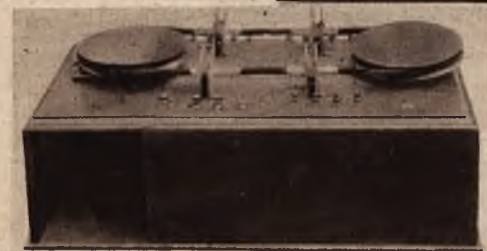
Pierwszy detektor magnetyczny, zbudowany przez Marconiego.
