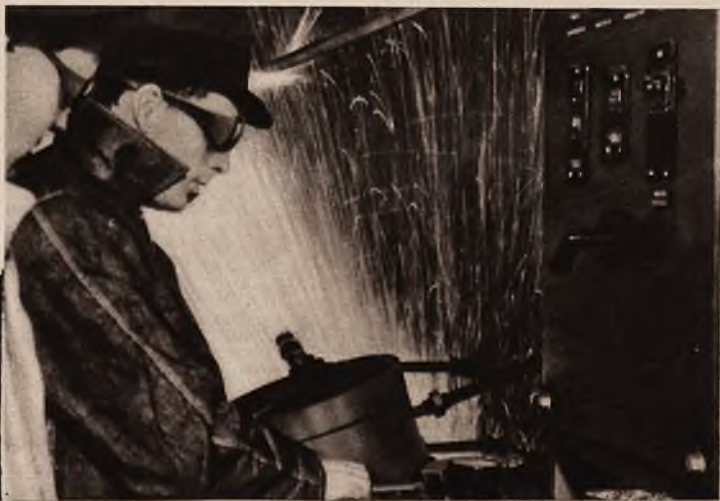
Spawanie długich pojedynczych części szyn odbywa się z pomocą elektrycznego aparatu. Klamry hydrauliczne przytrzymują te części podczas działania elektrycznego prądu.
