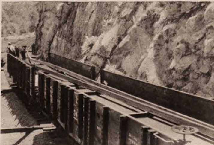
Kładzenie kilkuset-metrowych szyn odbywa się przy pomocy niskich wagonów, z których się one zesuwały, a wielka elastyczność szyn ułatwia układanie ich na torze kolejowym.
