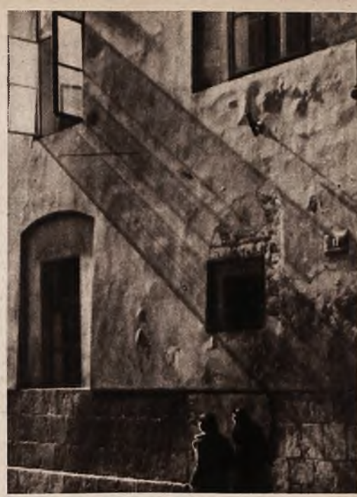
Mur gotycki z obrobionego wapienia.
