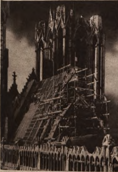
Na lewo: Podczas odbudowywania katedry wzniesiono szkielec dachu z żelazobetonu. („Illustration”).
