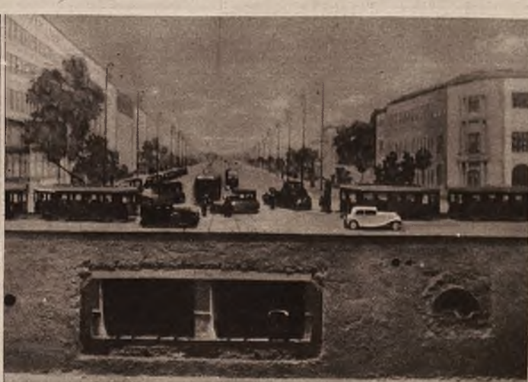
Fragment przekroju budującego się tunelu kolejowego w Warszawie, stanowi jeden z eksponatów Muzeum Kolejowego w Warszawie.
