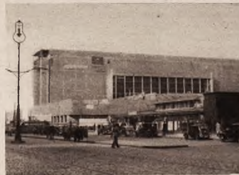
Budowa nowego dworca głównego.
