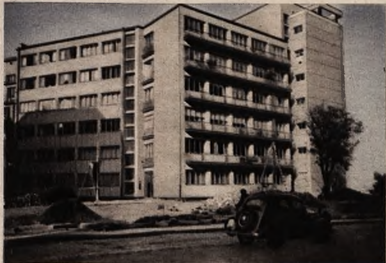
NOWOCZESNE BUDYNKI WARSZAWY: Luksusowy dom mieszkalny przy budującej się Alei na Skarpie.
