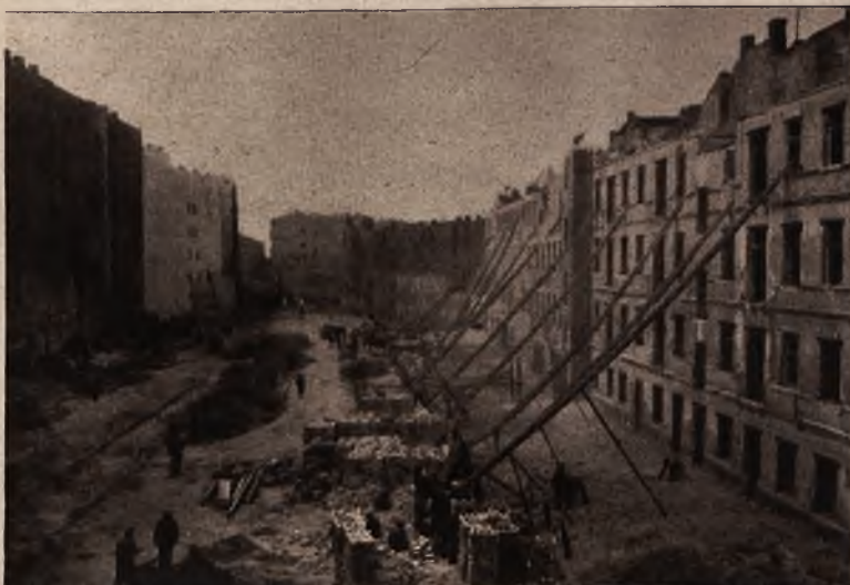
Rozbiórka domów przy ul. Bonifraterskiej dla przebiecia arterji reprezentacyjnej.
