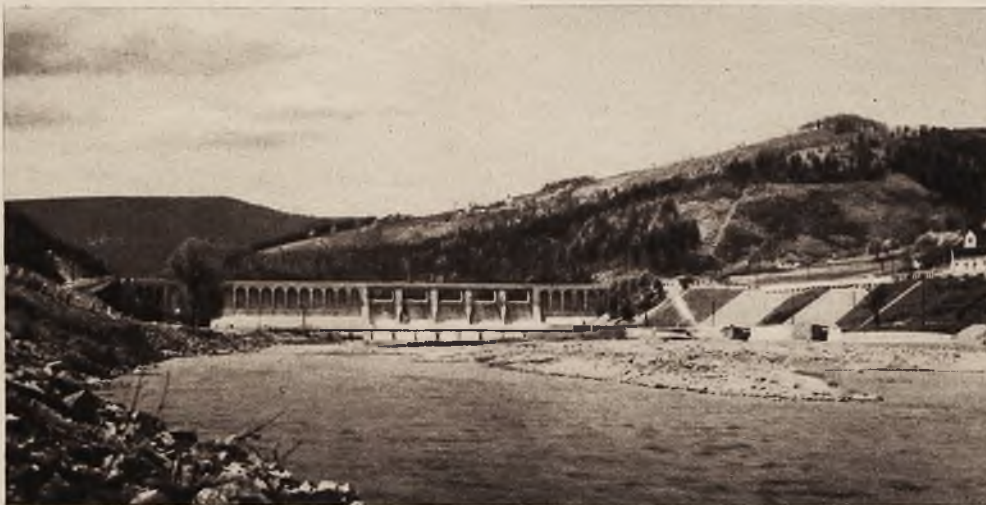
Sota poniżej zapory w Porąbce.
