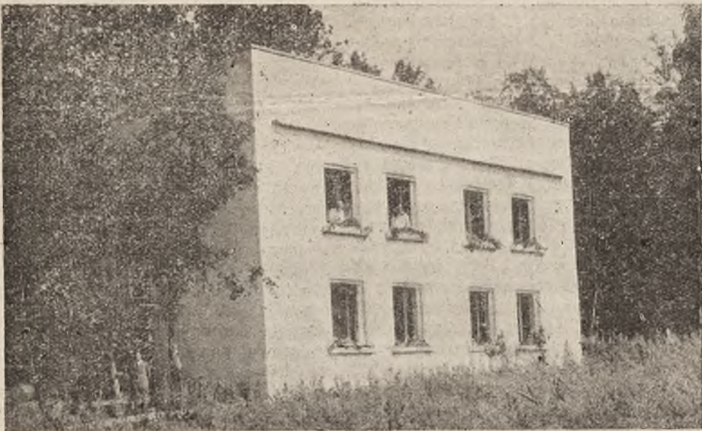
Latoszyn. — Dom mieszkalny.
