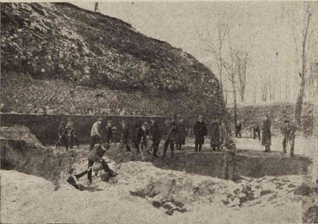
Rozpoczęcie budowy strzelnicy Związku Strzeleckiego im. płk. M. Kaplickiego w Krakowie.
