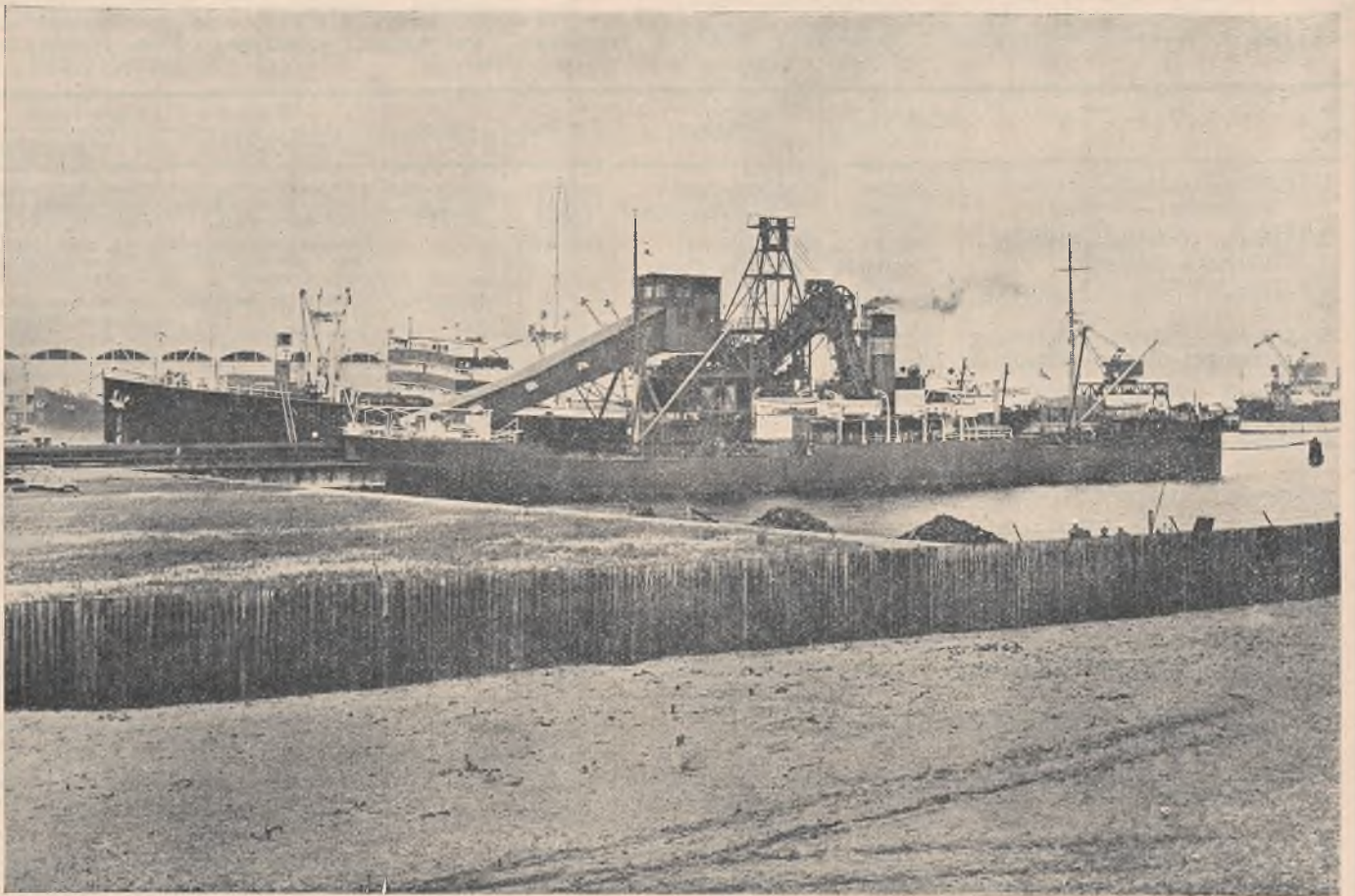
Taśmowe urządzenia firmy Skarbopol do ładowania węgla w Porcie Gdynskim
