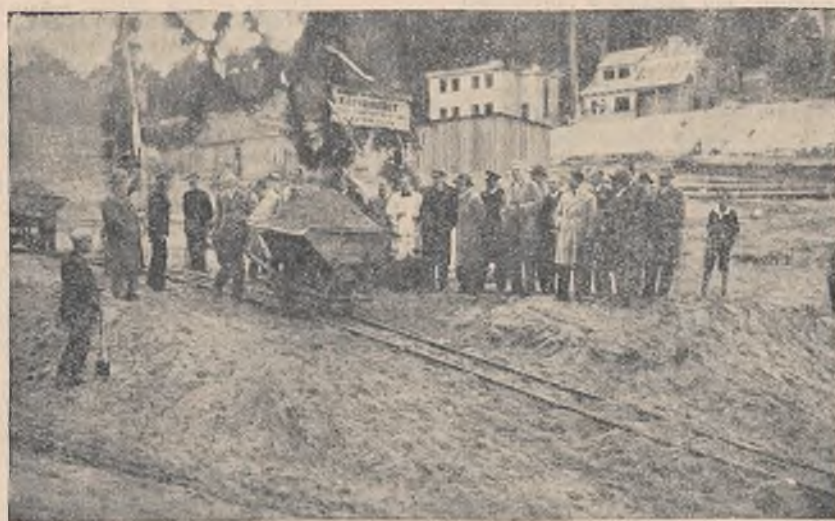
Poświęcenie robót drogowych na Witominie, rozpoczętych przez firmę „Kom-dro-bit“
