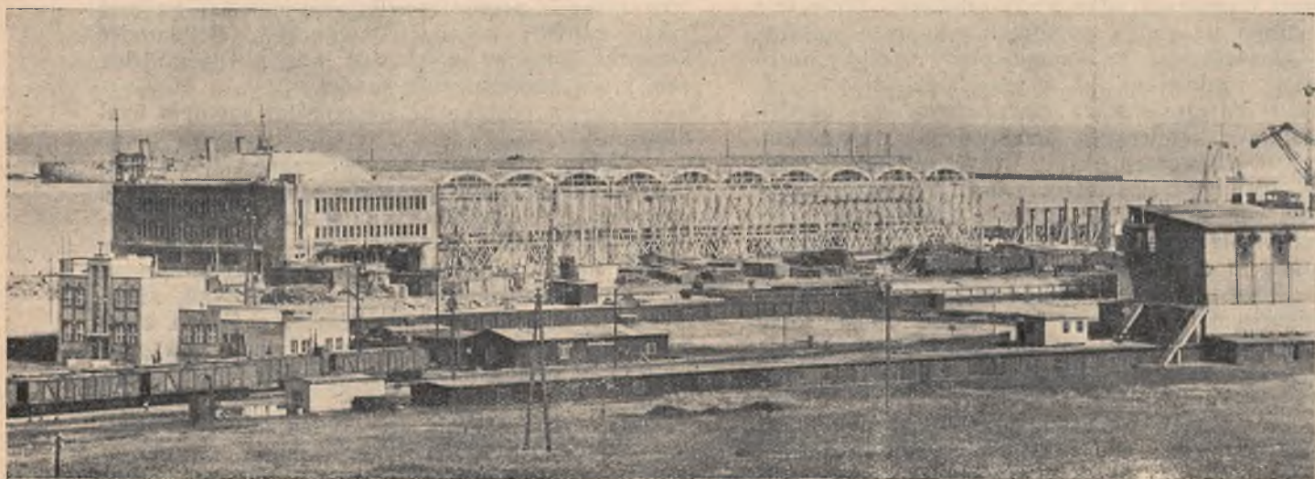
Budowa nowego dworca kolejowego w porcie gdyńskim
