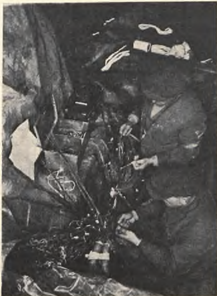
Rys. 4. Łączenie dwóch odcinków kabla
