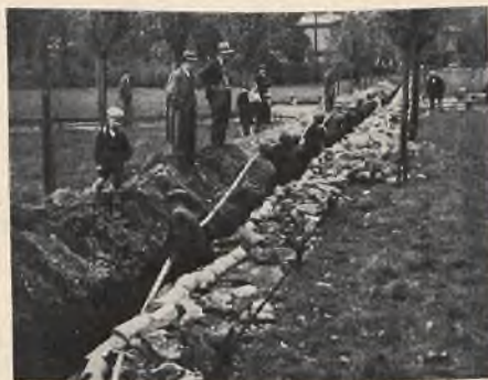
Rys. 3. Ręczne układanie kabła.
