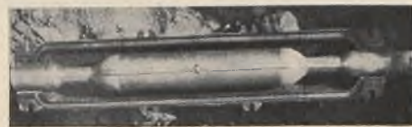
Rys. 5. Złącze po wykonaniu ze zdjętą pokrywą.
