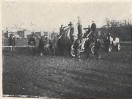
Rys. 2. Rozwijanie kabła przy układaniu maszynowym.
