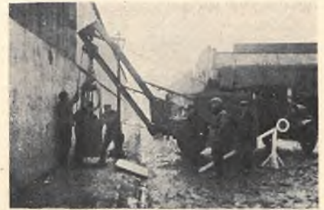
Rys. 6. Opuszczenie do studni skrzyni z cewkami Pupina.
