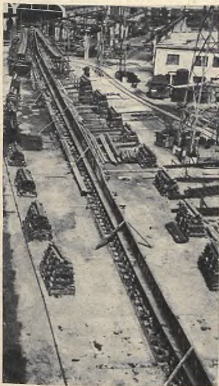
Fotografia przedstawia stępkę (środkową podstawową helkę dna) drugiego z okrętów, w dniu rozpoczęcia budowy, 1 maja 1934 r.
