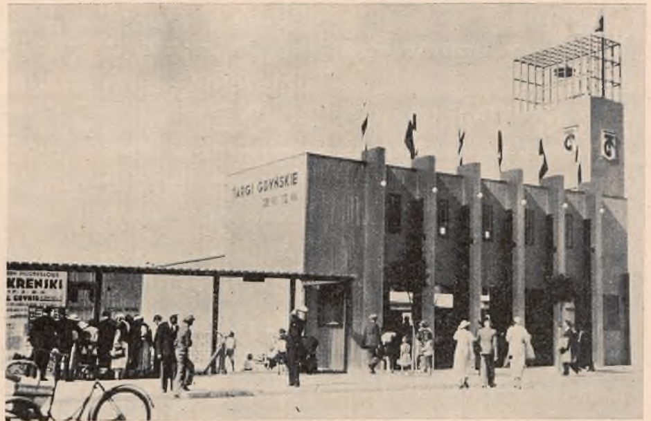
Targi Gdynskie. Wejście główne.
