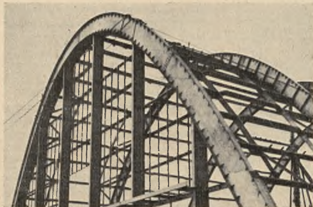
Konstrukcja żelazna hal targowych (w budowie)
