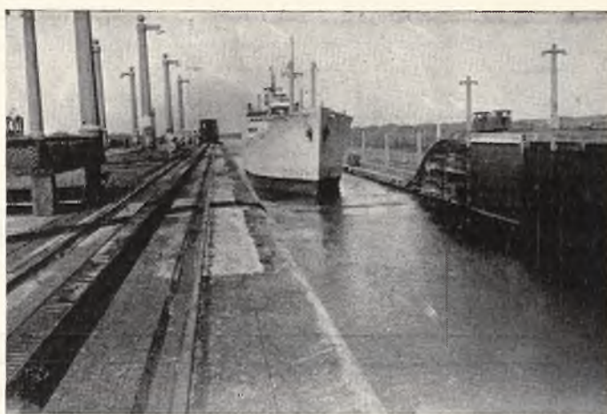
Elektryczne lokomotywy wciągają statek do śluzy
