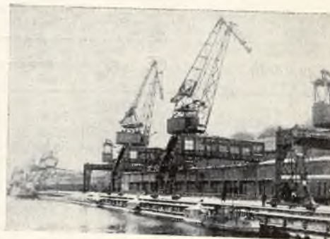
Nowozmontowane dźwigi na nabrzeżu Francuskim przy Dworcu Morskim
