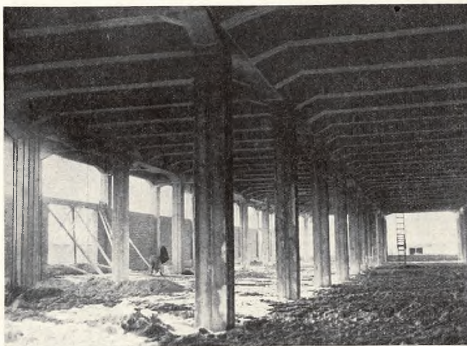
Magazyn w wolno-clowej strefie w budowie
