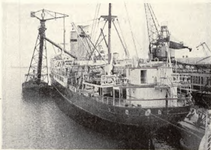
S/s „Kościuszko“ podczas postoju przy Dworcu Morsk. bierze bunker
