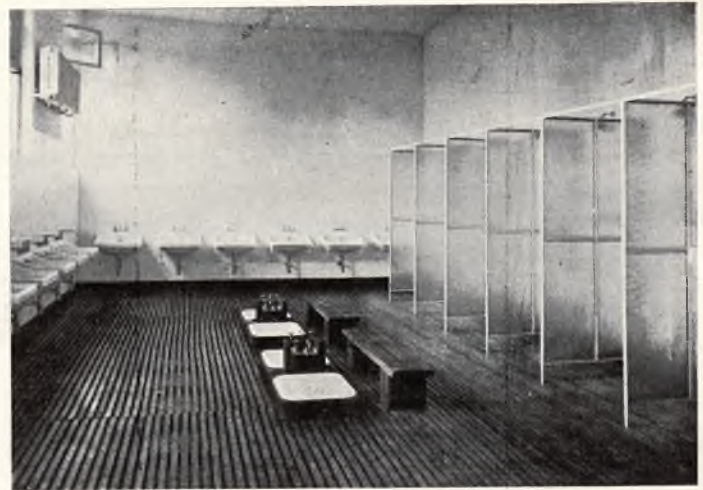
Fragment urządzeń sanitarnych dla robotników firmy „Polskarob“ (umywalnie i natryski)
