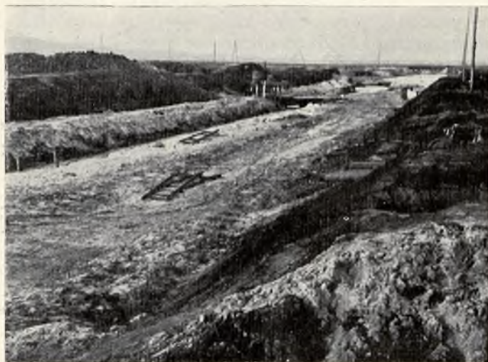
Budowa kanału Przemysłowego w Gdyni The construction of the Industrial Canal in Gdynia
