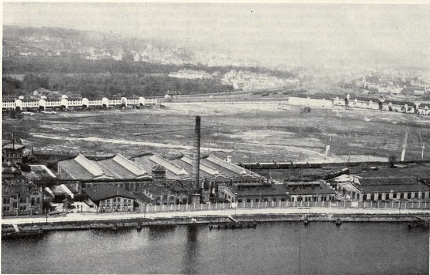
Ogólny widok Fabryki Wagonów Gdańsk. — Gesamtansicht der Waggonfabrik Danzig.
