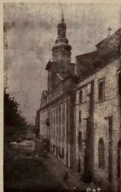
Miasta pomorskie posiadają szereg cennych zabytków budowlanych, pochodzących z czasów średniowiecza. Do rzędu z najbogatszych pod tym względem miast pomorskich należy Grudziądz. Jednym z najpiękniejszych budynków w tem mieście jest obecny ratusz, dawniej kolegium jezuickie.
