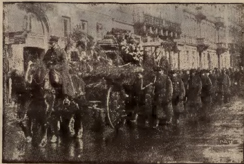
W dniu wczorajszym odbył się pogrzeb ofiary tragicznego wypadku, zatrucia gazem świetlnym, ś. p. pułkownika-pilota Jana Sendorka, p. o. Szefa Departamentu Aeronautyki w Ministerstwie Spraw Wojskowych. — Zdjęcie nasze przedstawia kondukt pogrzebowy, zdążający przez ulicę Kredytową.
