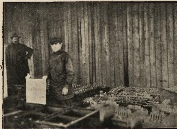
Sala montowni największych akumulatorów, waga niektórych sięga do 1000 kg. Fot. „Autolot”.
