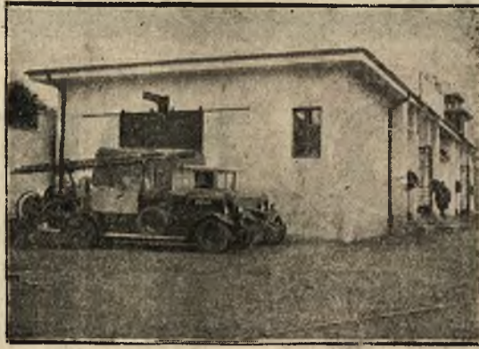
Na wystawie powszechnej wystawiony został wóz strażacki na podwoziu typu A „Ursus”. Całkowite urządzenie przyrządów nadwozia wykonane zostało przez firmę „EMWEL” w Warszawie.
