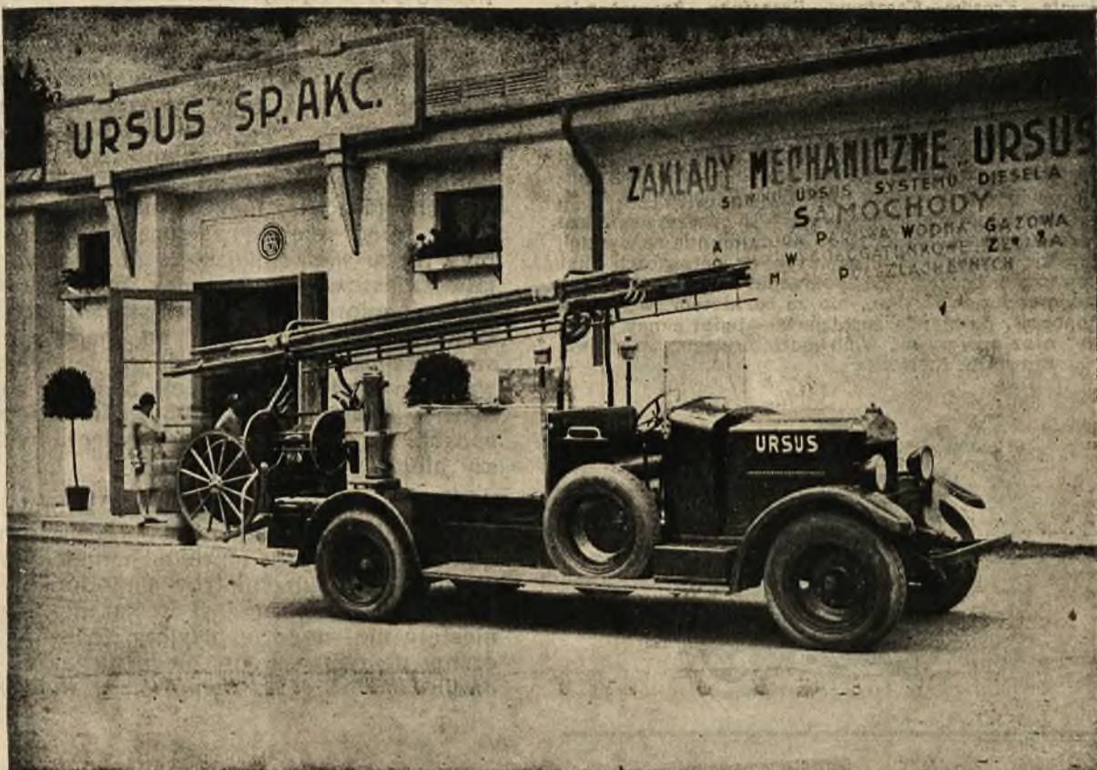
Na Powszechnej Wystawie Krajowej, wystawiony został wóz strażacki na podwoziu typu A „URSUS“, całkowite urządzenie nadwozia i przyrządów pożarniczych zostało wykonane przez Zakłady „EMWEL“ w Warszawie.
