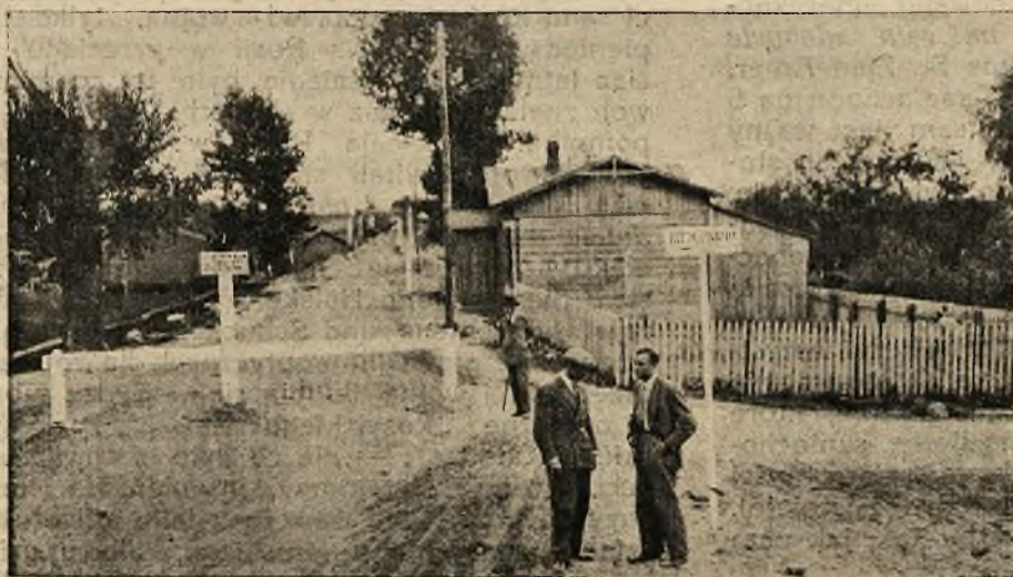
Właściwa droga do Poznania, zamknięta na czas przebudowy mostu.
