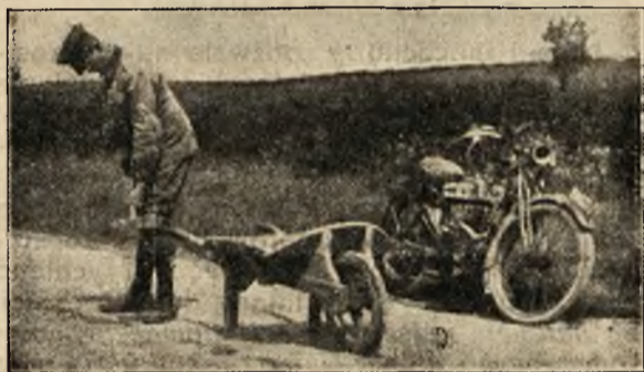
Motocyklowe patrole A. A. zasypują wyrwy i dołki na szosie.
