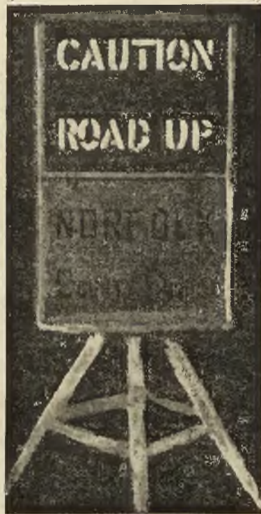
Fotografia nocna sygnału drogowego, wykazująca wyrazistość liter; dolna część została w reprodukcji wzmożona, celem wykazania konstrukcji dolnej części sygnału
